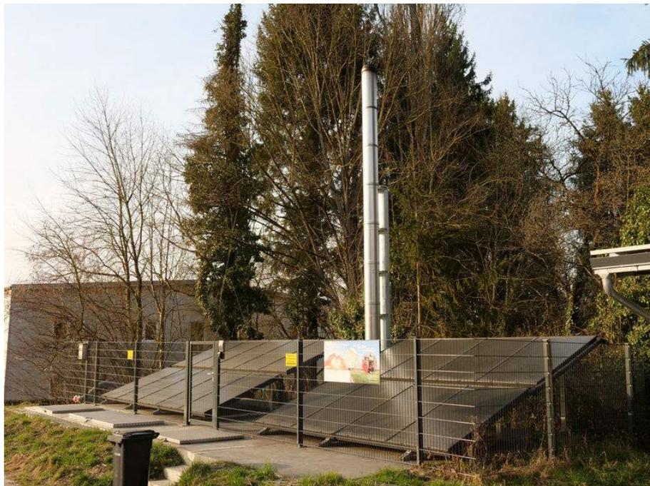
Nahwärmezentrale Mauer:  $40m^2$  Solarwärmekollektor
